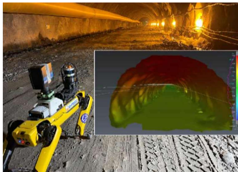
[그림 3.10] 무인로봇과 LiDAR를 이용한 터널 계측 사례
