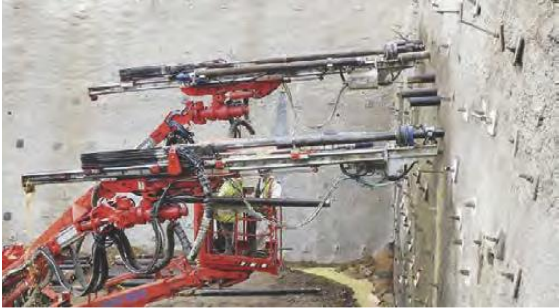
[그림 5.1] AT squeezing unit을 장착한 천공기
